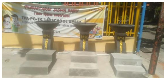
Gambar 3. Pemasangan wastafel di TK Labschool UNESA
