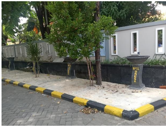
Gambar 2. Pemasangan wastafel di Labschool UNESA kawasan Ketintang
