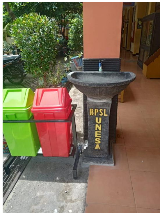
Gambar 1. Pemasangan wastafel di Labschool UNESA kawasan Lidah
